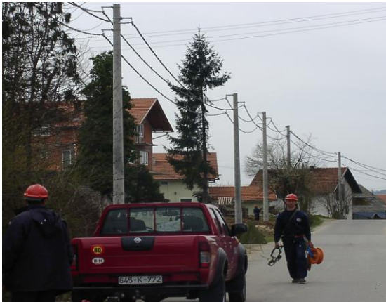
Реконструкција ДВ 10 kV изграђеног на дрвеним стубовима употребом АБ стубова и СН СКС-а
