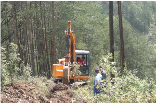
Рад на реконструкцији ДВ 10 kV (надземна дионица, израда подземног 10 kV вода)
