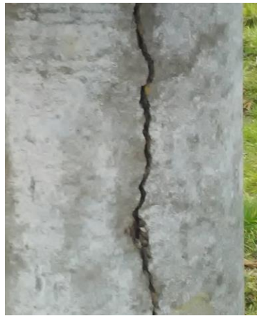
Подужно попуцао АБ нисконапонски стуб, оштећење констатовано кроз ревизију НН мреже, неопходна замјена
