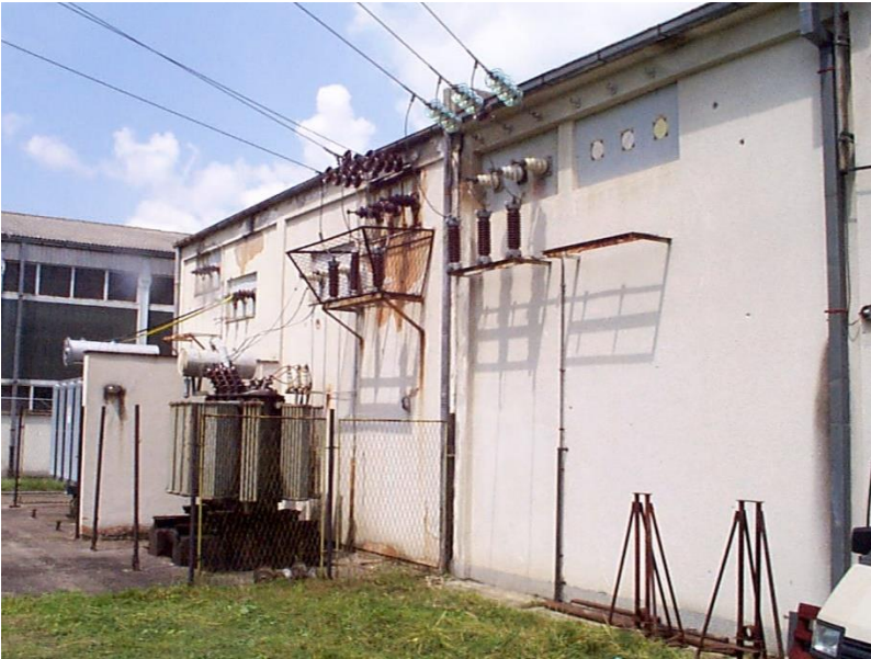
Изглед фасаде на ЧТС 35/10 kV „Руданка“
