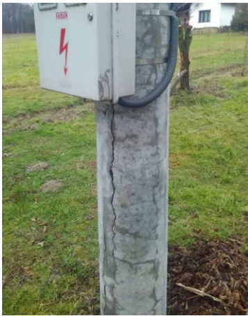
Подужно попуцао АБ нисконапонски стуб, оштећење констатовано кроз ревизију НН мреже, неопходна замјена
