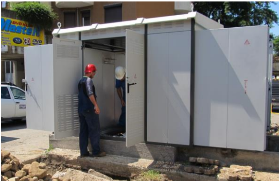
Радови на замјени БТС 10/0,4 kV
