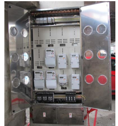
Санација и реконструкција ММ код групних прикључака
