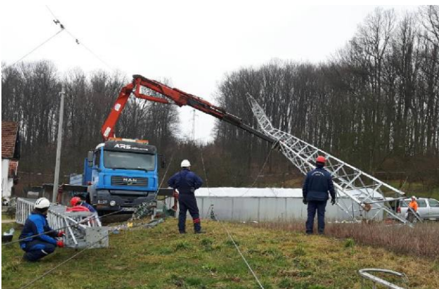
Замјена оштећеног стуба на ДВ 35 kV
