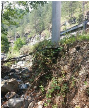
Далеководни стуб угрожен ерозијом терена (ДВ 10 kV изграђен на АБ стубовима употребом СН СКС-а)
