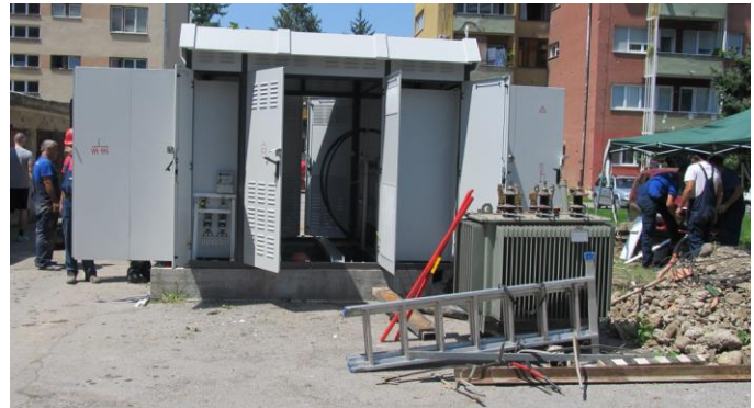
Радови на замјени БТС 10/0, kV
