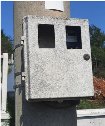
Дотрајали мјерно – прикључни ормари на нисконапонским прикључцима које је потребно замјенити
