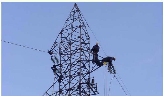
Замјена изолаторских ланаца на ДВ 10 kV
