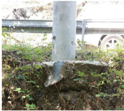
Далеководни стуб угрожен ерозијом терена (ДВ 10 kV изграђен на АБ стубовима употребом СН СКС-а)
