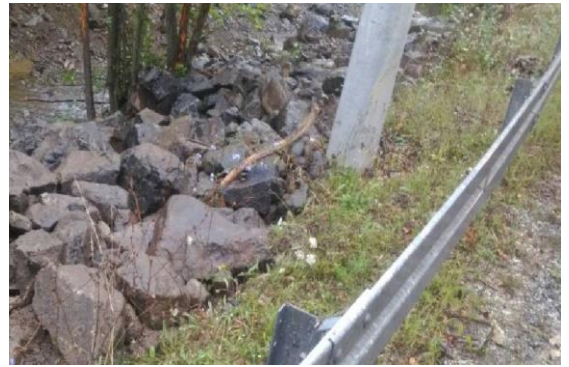
Санација терена изградњом потпорног зида испод далеководног стуба
