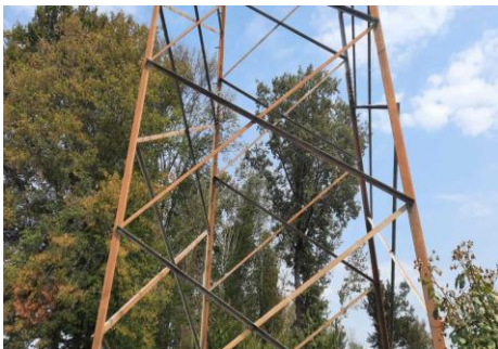
Кородирана конструкција стуба на ДВ 35 kV
