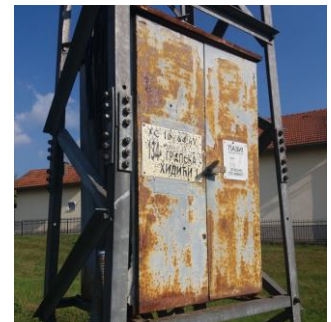
Кородирало кућиште НН ормара на ТС 10/0,4 kV
