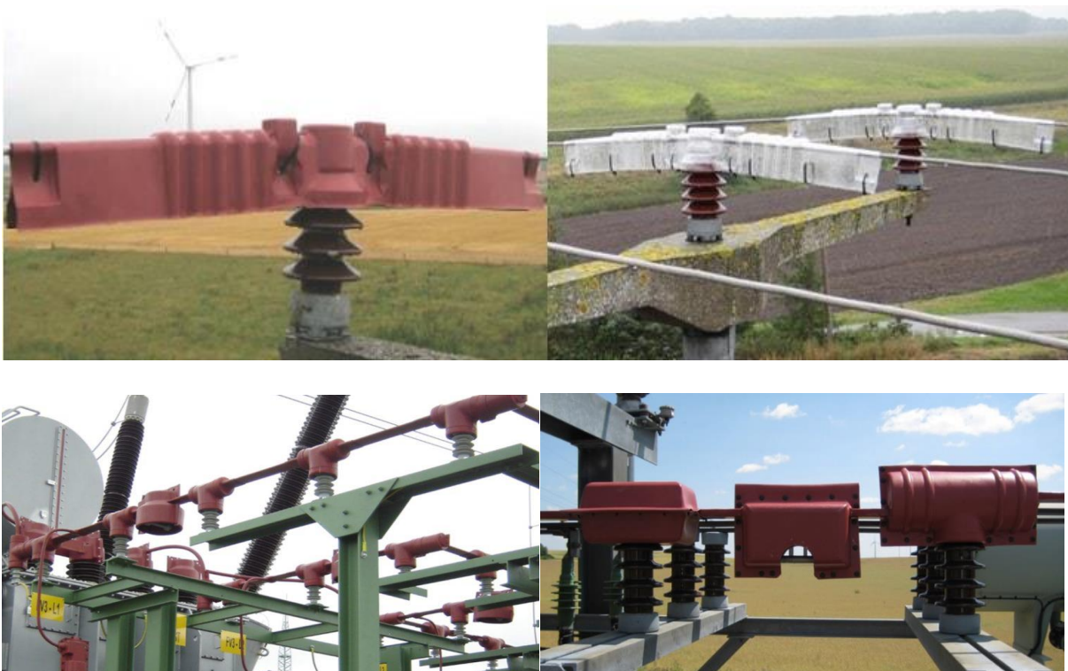
Слике изолационих браника ради спречавања случајног дјеловања животиња.
