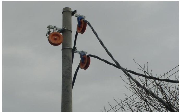
Реконструкција ДВ 10 kV изграђеног на дрвеним стубовима употребом АБ стубова и СН СКС-а
