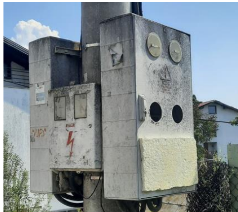
Дотрајали мјерно – прикључни ормари на нисконапонским прикључцима које је потребно замјенити
